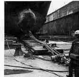
Das Vorschiff wird mit Hubzügen auf vorbereiteten Schlittenbahnen vorgezogen.
