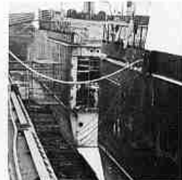
„Alafoss“ im Schwimmdock der HDW, Schiff bereits getrennt, auseinandergezogen, die Lücke wird gefüllt.
